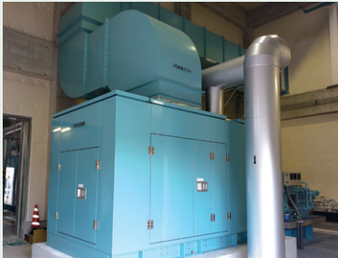
排水機場 (大分県) For drainage pumping station (Oita) 出力 189kW (防音型)
