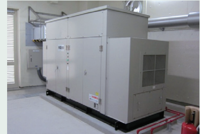
排水機場ポンプ設備予備用(徳島県) EG for drainage pumping station (Tokushima) MAS-82S(82kVA) 空冷式/屋内設置
