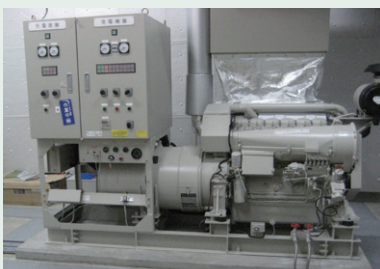
電力会社無線通信中継所予備用(千葉県) EG at radio relay station of electric power company (Chiba) MAB-100(100kVA) 空冷式
