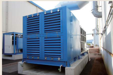
KP300SE型除湿機 KP300SE Type Dehumidifiers
