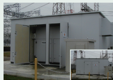
電力会社無線通信中継所予備用 (東京都) EG at radio relay station of electric power company (Tokyo) MAS-55SSS (55kVA) 空冷式 極超低騒音型
