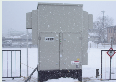
鉄道信号機予備用(福島県) EG for railway signals (Fukushima) MAS-5SS(5kVA) 空冷式 積雪対策型、寒冷地仕様(-20℃)
