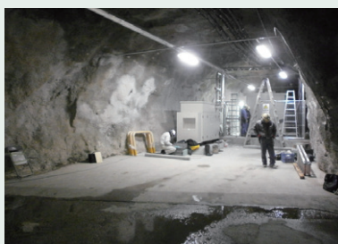
神岡宇宙素粒子研究施設用 (岐阜県) EG at Kamioka Observatory (Gifu) MAS-50S (50kVA) 空冷式
