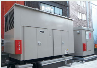
鉄道駅防災用(東京都) EG for railway station disaster prevention (Tokyo) MAC-280SS(280kVA) 空冷式
