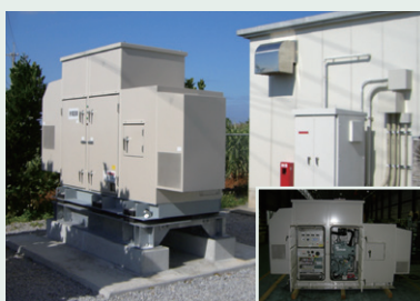
携帯電話中継基地局予備用 (沖縄県) EG at mobile relay station (Okinawa) MAS-20S (20kVA) 空冷式 塩害対策型、防風雨対策型
