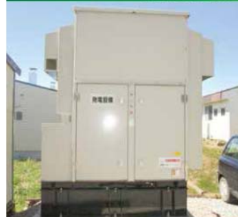
MAS-5SS 5kVA -30℃積雪対応寒冷地仕様
