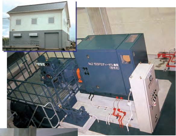
土木事務所所轄排水機場
