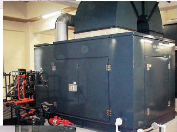
土木事務所所轄排水機場
