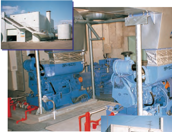
国土交通省所轄排水機場
