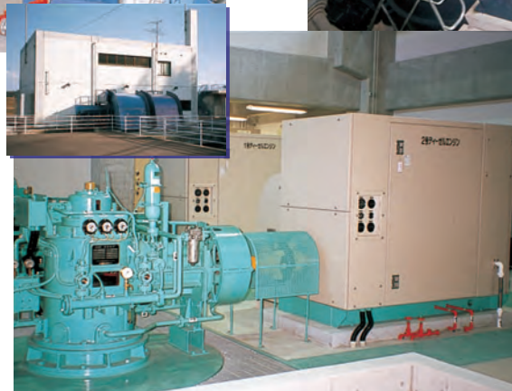
土木事務所所轄排水機場
